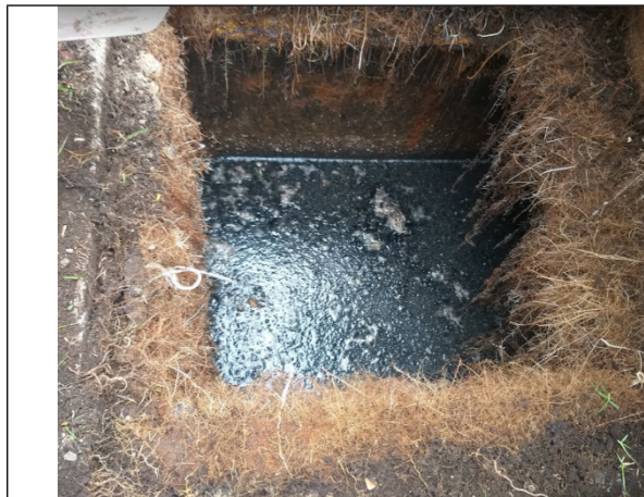
Foto 5. Caja de inspección 2.
